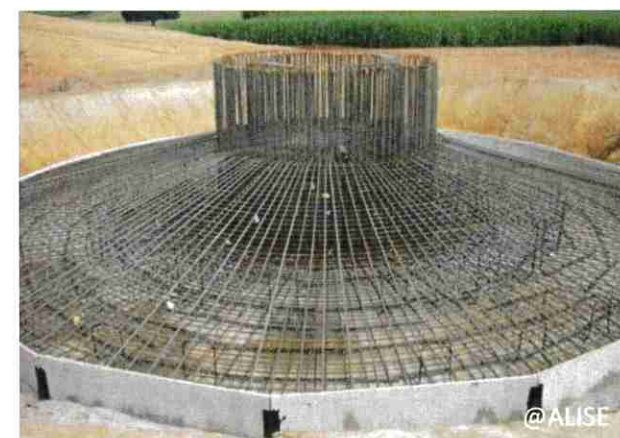
Photo 5 : Excavation et préparation de l'armature
